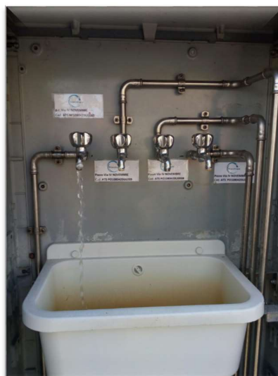
Campionamento di acqua post-trattamento di punti rete quali fontanelle ad apertura manuale e armadietti custoditi
