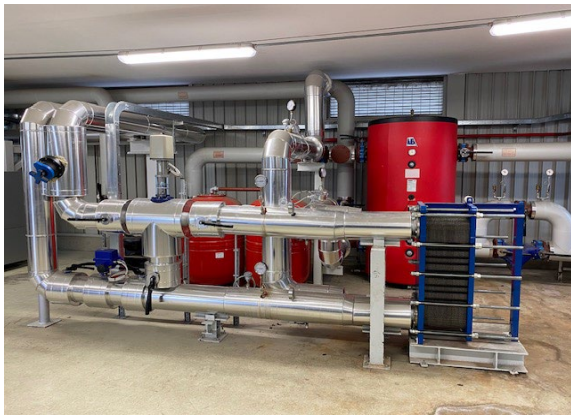
Figura 2 impianto centrale di riscaldamento, con vasi di espansione chiusi, servito da scambiatore di calore
